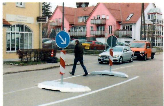
Abbildung 1 Beispiele für temporäre Verkehrsinseln zur Sicherung von Fußgängerüberwege
